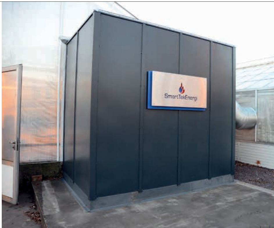
Den første avfukteren ble montert utendørs. Varm, tørr luft blir pumpet inn i et veksthus på et drøyt mål.
